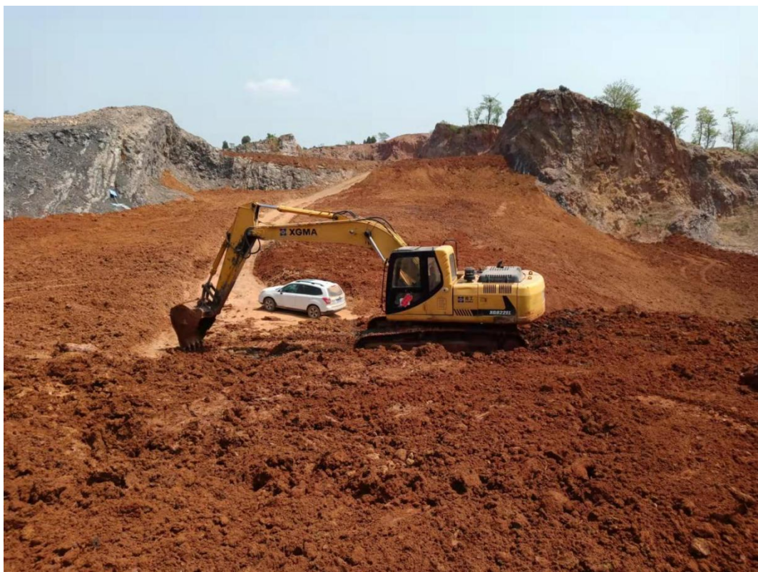
图 2-6*****治理区施工中照片
